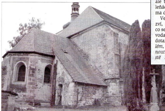
Kostel v Malé Veleň má zatím opravenou jen střechu. V budoucnu by v něm chtěl starosta pořádat výstavy. Foto Tomáš Pavlík
