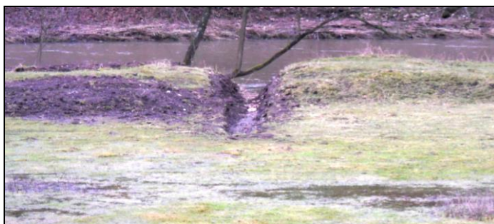
Prostor u Ploučnice býval upraven tak, aby se hřiště mohlo změnit na kluziště. Vytvořený val u řeky zadržel vodu, která se v době mrazů čerpala hasičskou stříkačkou z řeky. Dnes je val prokopaný.
